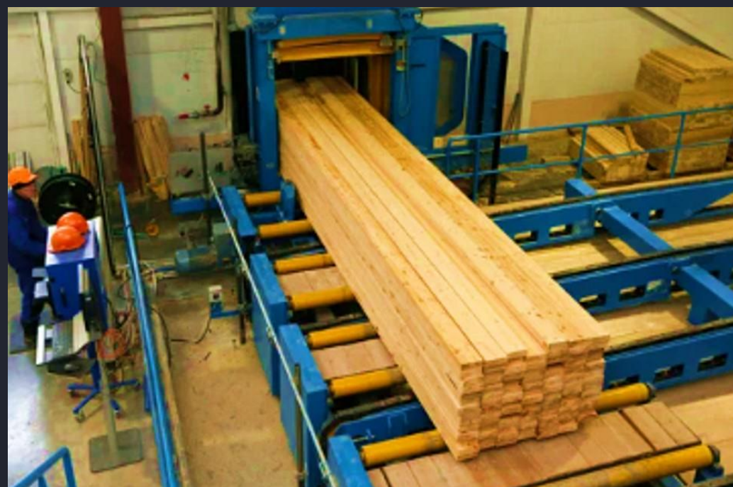
СТРОИТЕЛЬСТВО ЛЕСОПЕРЕРАБАТЫВАЮЩЕГО КОМПЛЕКСА ООО «ЕВРОСИБДОМ»
